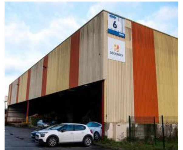
Implantée au port fluvial, l'usine compte 6 000 m 2 de bâtiments.
